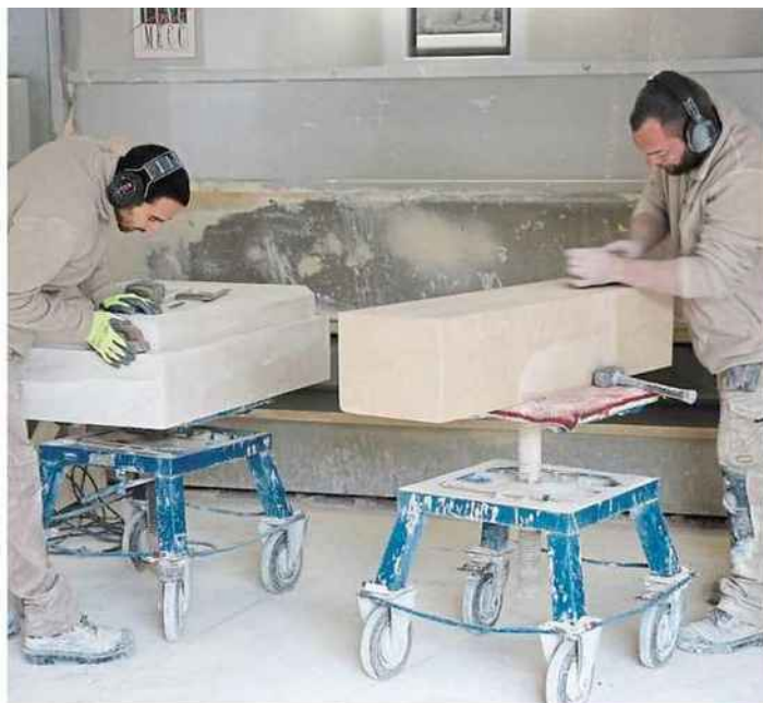
Les blocs prennent forme, selon les instructions de l'appareilleur.
