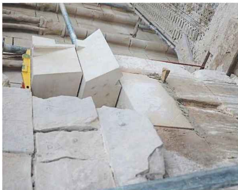
La touche finale : insérer la pierre au clocher de l'église. | CREDIT PHOTO : OUEST-FRANCE
